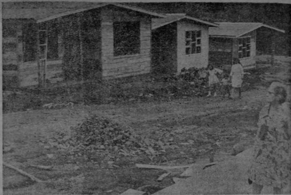
Estas son las viviendas que el IMAS construye en el programa que realiza en Itiquís de Alajuela. La Prof. Olimpia Trejos, derecha, del Consejo Directivo de IMAS recorre las obras durante una visita que realizó a esa comunidad.
